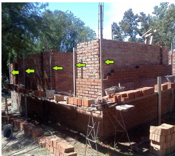
Figura 1. Vista general de dos paredes de ladrillo visto con reglas colocadas
