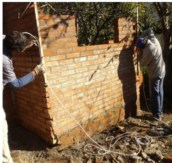
Figura 3. Utilización de manguera de nivel.
